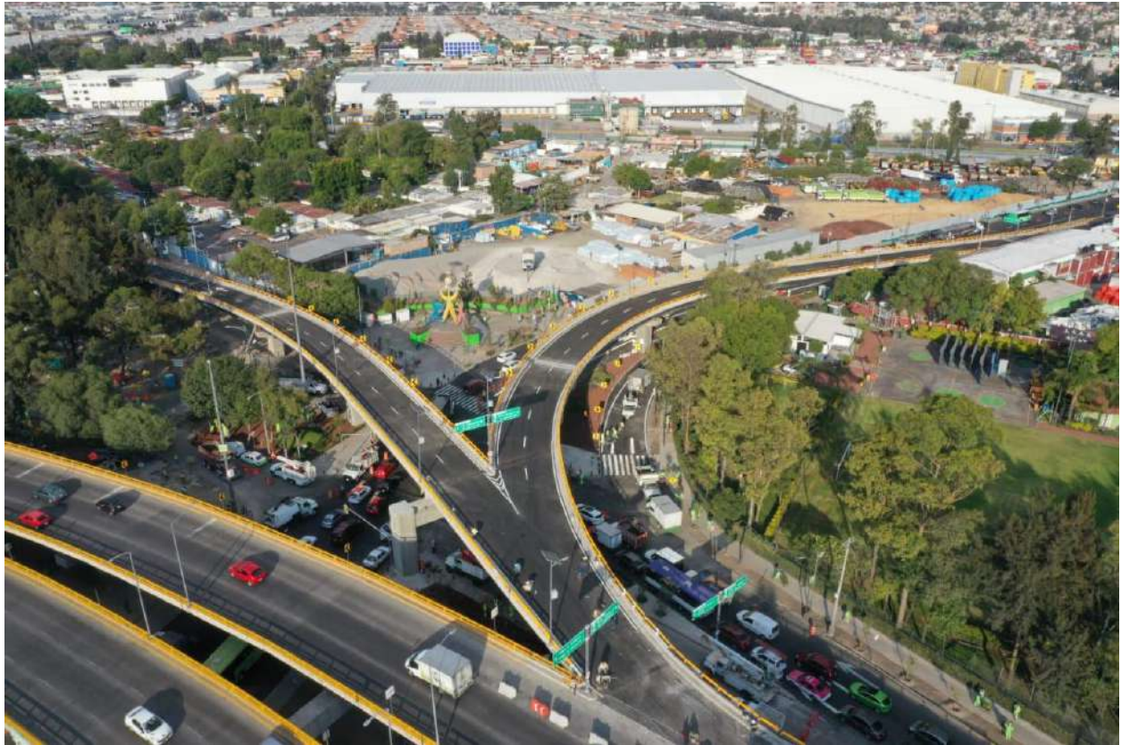
Ilustración 27. Adecuación del Puente Vehicular de Circuito Interior y Eje 6 Sur
